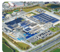
2020年4月に稼働した(株) 明治九州工場の太陽光発電設備
