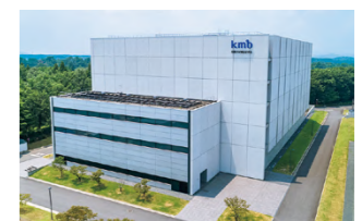
KMバイオロジクス(株)FC棟 原液製造施設
