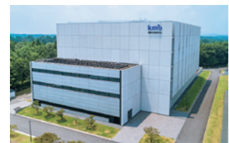
KMバイオロジクス (株) FC 棟 原液製造施設
