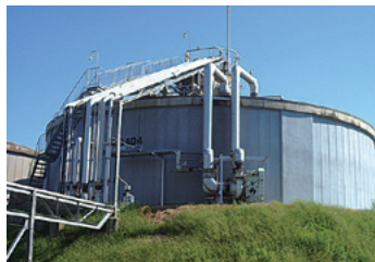
岐阜工場のメタン発酵槽。汚泥をメタン発酵させてメタンガスで蒸気を作り、発酵かすはセメント原料に利用しています。
