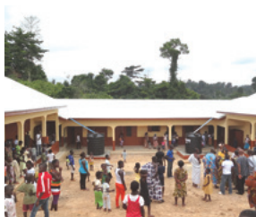
完成した小学校
