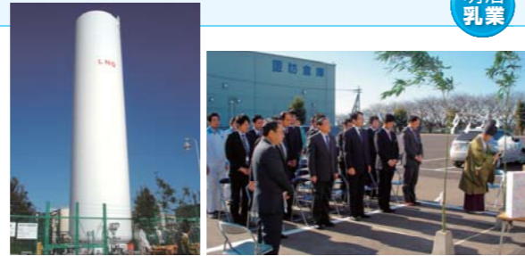
施工の様子とLNG貯蔵タンク
