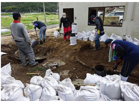
2018年10月 岡山県倉敷市真備町
