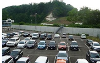
日本罐詰（株）の防水壁
