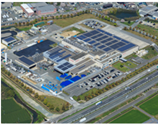
2020年4月に稼働した(株)明治九州工場の太陽光設備
