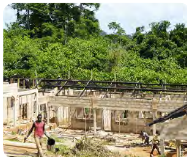
小学校建設の様子
