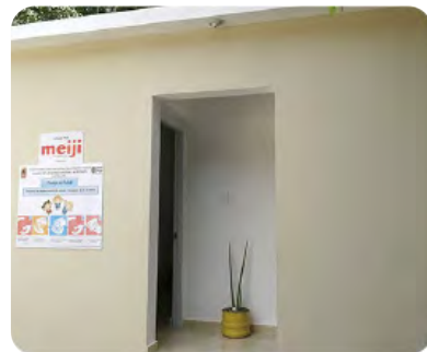
新設のトイレ
