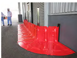
Meiji Seika ファルマ(株)小田原工場の仮設止水板
