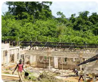
小学校建設の様子
