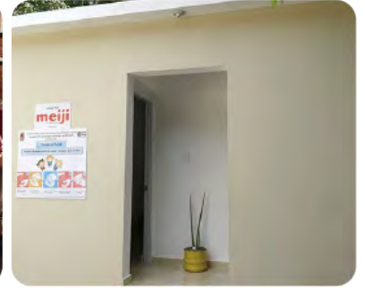
新設のトイレ
