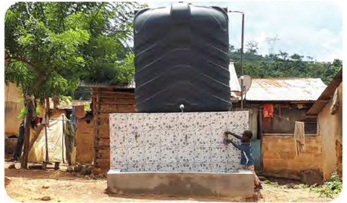
建設した貯水タンク付きの井戸
