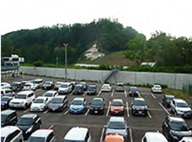
日本罐詰(株)の防水壁
