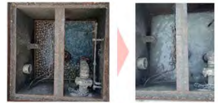
四国明治(株)松山工場でのBN菌の機能を生かした油汚れ(オイルボール)の解消
