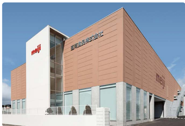
製造設備の充実を図った社屋
