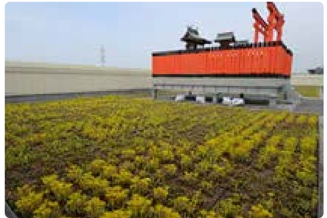
乾燥に強い多肉植物のセダム(メキシコマンネングサ)を用いて屋上を緑化
