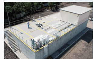
PT.メイジ・インドネシア・ファーマシューティカル・インダストリーズ 活性汚泥処理システム
