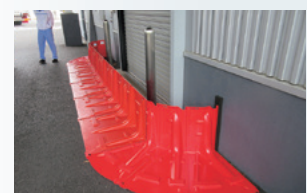
Meiji Seika ファルマ(株) 小田原工場での仮設止水板の設置訓練の様子
